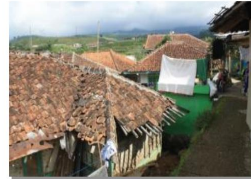
Perumahan /permukiman kumuh di Daerah Rawan Longsor
