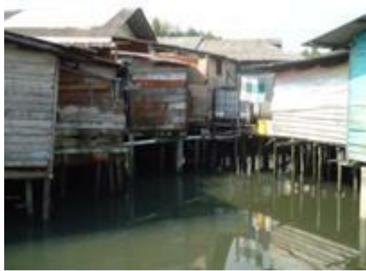
Perumahan /Permukiman Kumuh di Atas Air
