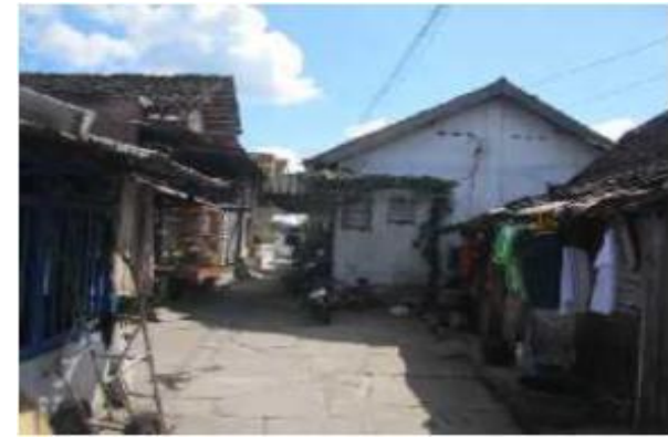
Perumahan /permukiman Kumuh di Dataran Rendah
